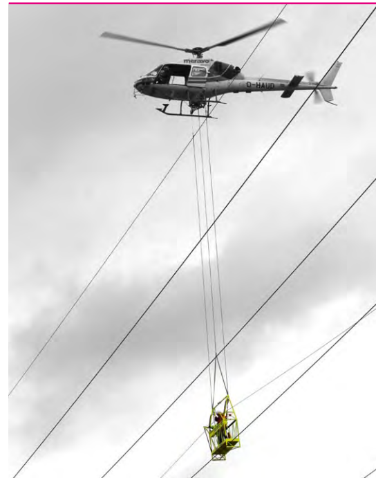
Reparaturen aus der Hubschraubergondel sehen spektakulär aus. Sie sind jedoch eine sehr sichere und effiziente Arbeitsmethode bei Schäden an Hochspannungsleitungen.
