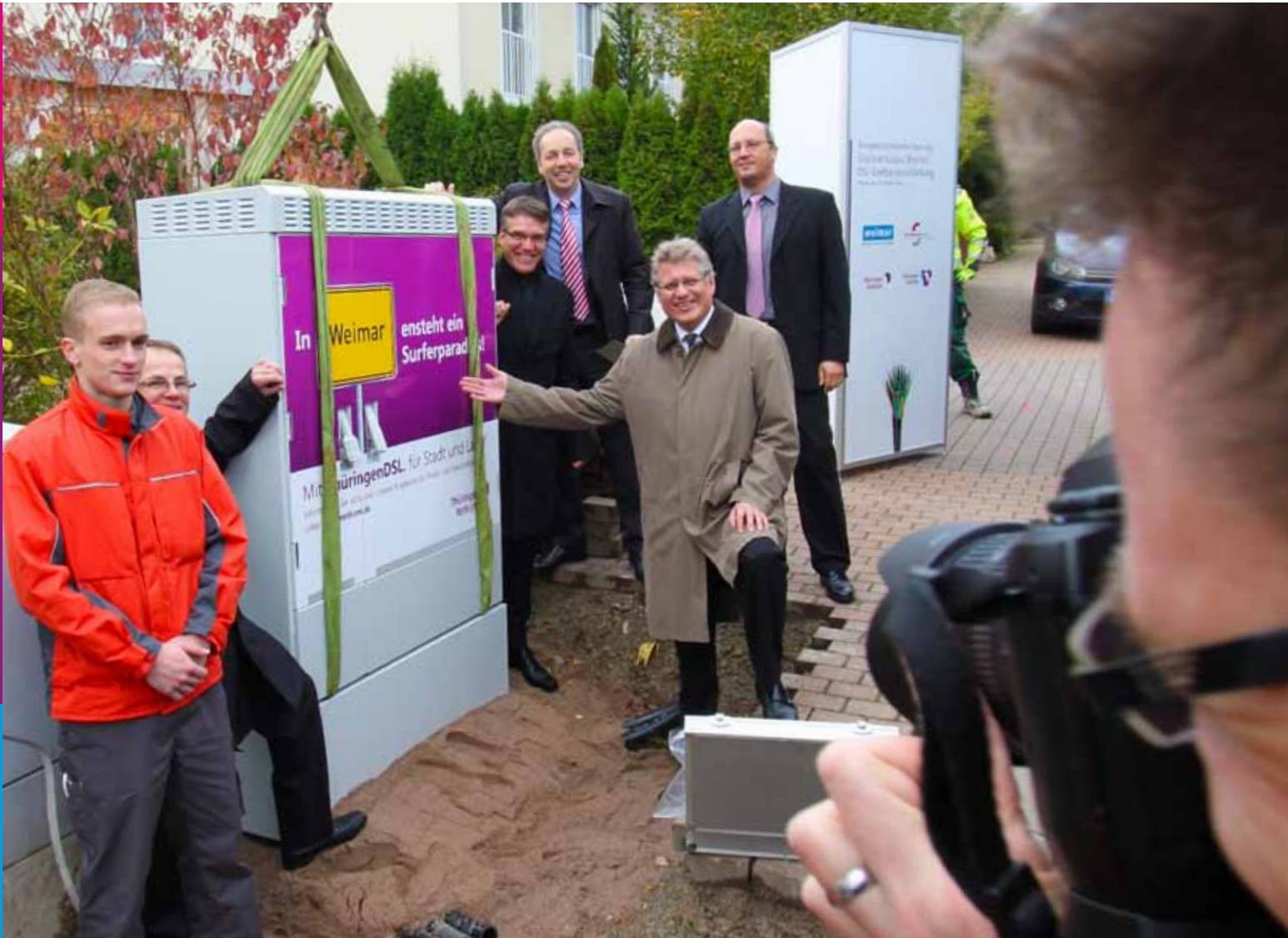
Kooperation mit Fundament – am 23. Oktober 2014 starten die Stadtwerke Weimar, die Thüringer Netkom, die Stadt Weimar und die TEAG ihr Kooperationsprojekt zur Glasfaserschließung in der Klassikerstadt. Einer der ersten Verzweigerkästen wird in der Alexander-Olbricht-Straße gesetzt.
