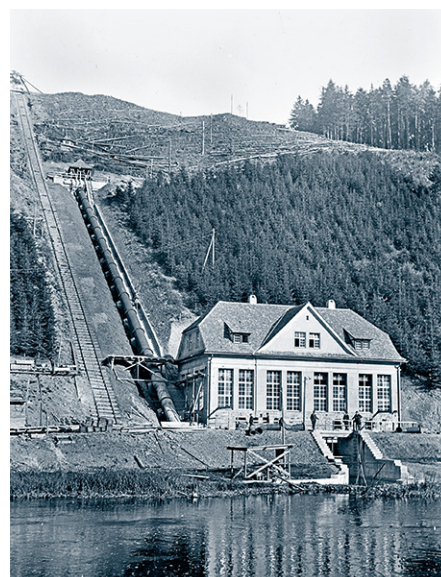
Spitzkraftwerk Wiesenthal, 1920, Foto: Archiv Vattenfall Wasserkraft GmbH
