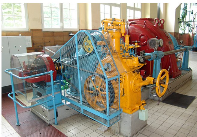
Maschine D im Betrieb, 2020, Foto: Thüringer Museum für Elektrotechnik e.V.
