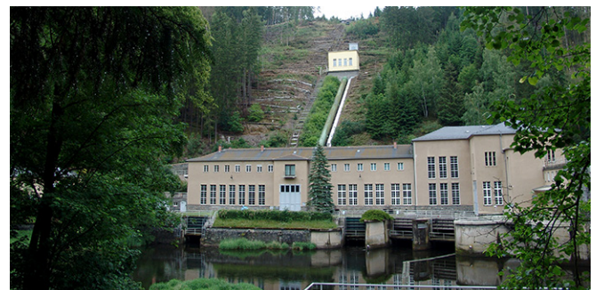
Wisenta-Kraftwerk, 2020, Foto: Thüringer Museum für Elektrotechnik e.V.
