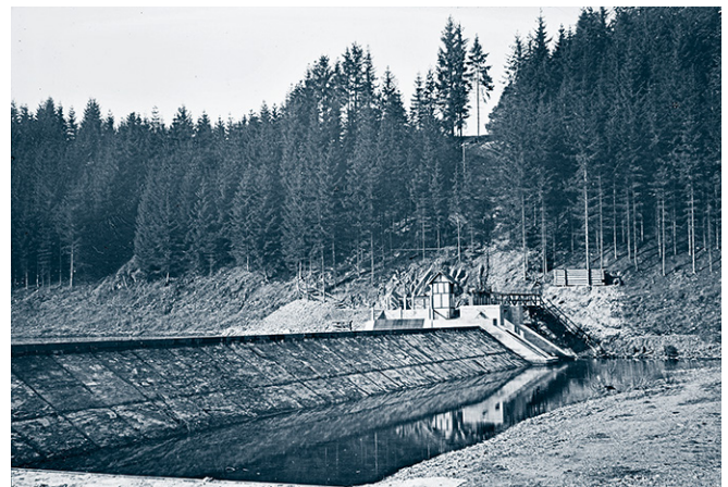
Luftseite des Steinkistenwehres mit Tosbecken, 1920, Foto: Archiv Vattenfall Wasserkraft GmbH
